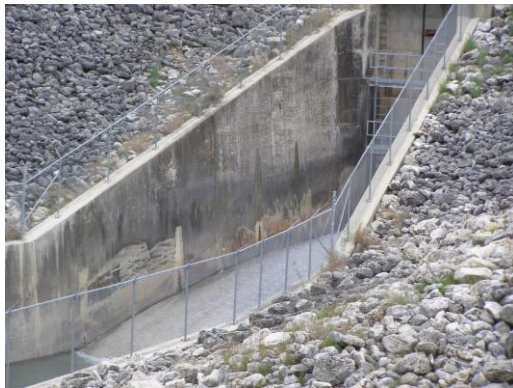
Figure 2-10. Outlet Conduit
