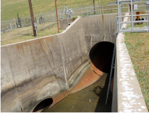
Figure 2-10. Outlet Conduit
